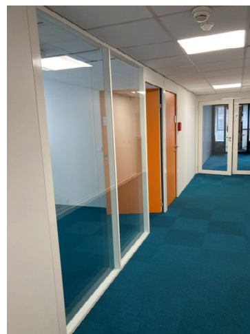
Photographie n°4 Cloisons modulaires pleines / vitrées alu laqué blanc
